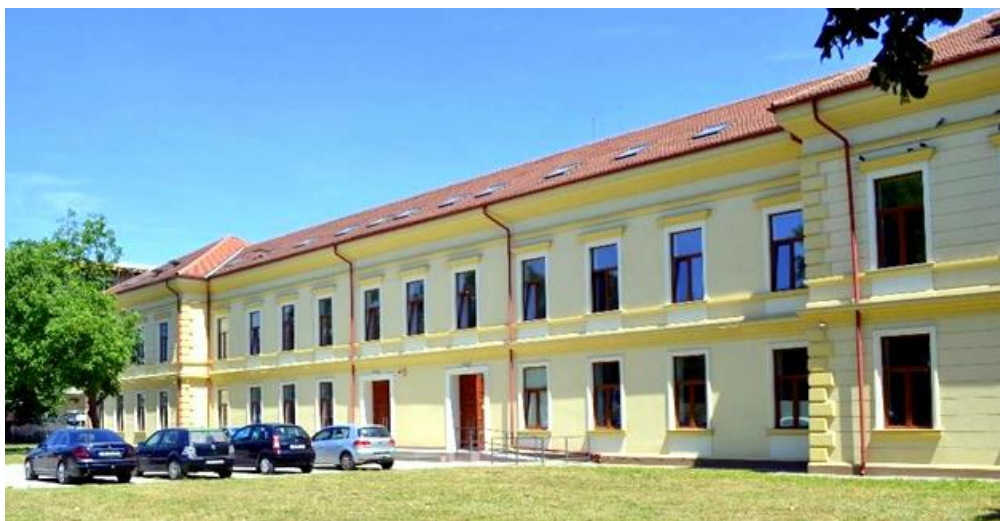
Fațada de vest a clădirii, la finalul lucrărilor de reabilitare din 2022, noua înfățișare luminoasă a fostei cazărmi.
